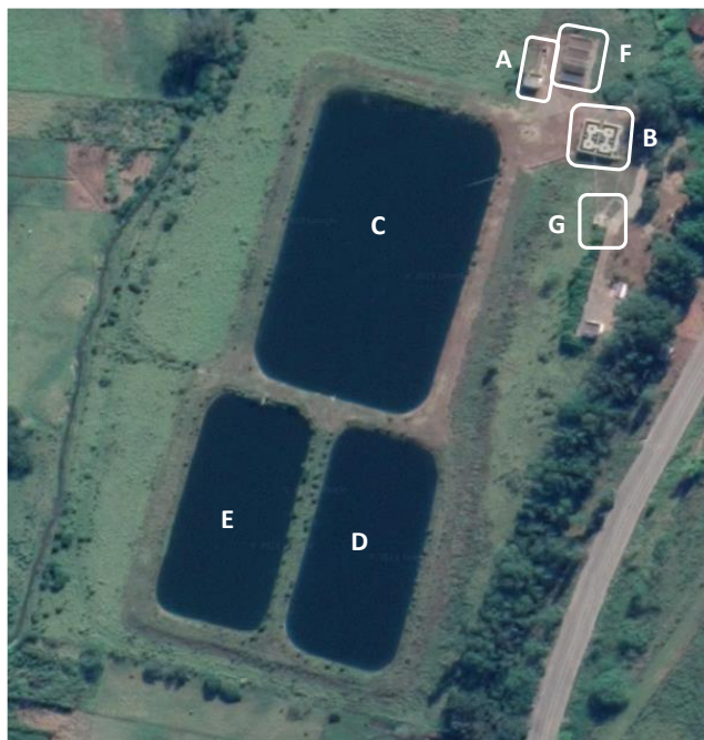
Figura 2. Vista aérea da ETE Capim Fino (Pedralva-MG): A – Grade + Desarenador; B – Reator Anaeróbio; C – Lagoa de Estabilização Facultativa; D e E – Lagoas de Polimento em Série; F – Leito de Secagem do Lodo; G – Queimador do Biogás. Fonte: Google Earth.
