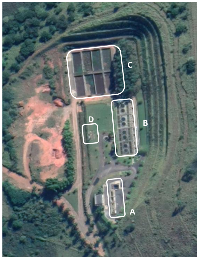
Figura 3. Vista aérea da ETE Sapucaí (Itajubá-MG): A – Gradeamento + Desarenador; B – Reatores Anaeróbios em Paralelo (4); C – Leitões de Secagem do Lodo; D – Queimador do Biogás. Fonte: Google Earth.
