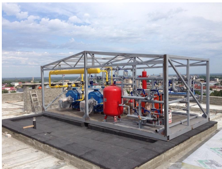
Рис. 1 – Крышная газовая котельная в стадии монтажа
